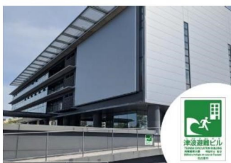
愛知時計電機本社ビル
